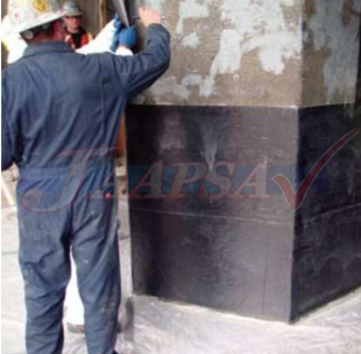
El sistema REFC proporciona el balance de propiedades más adecuado para reforzar y/o reparar estructuras dañadas de concreto.
