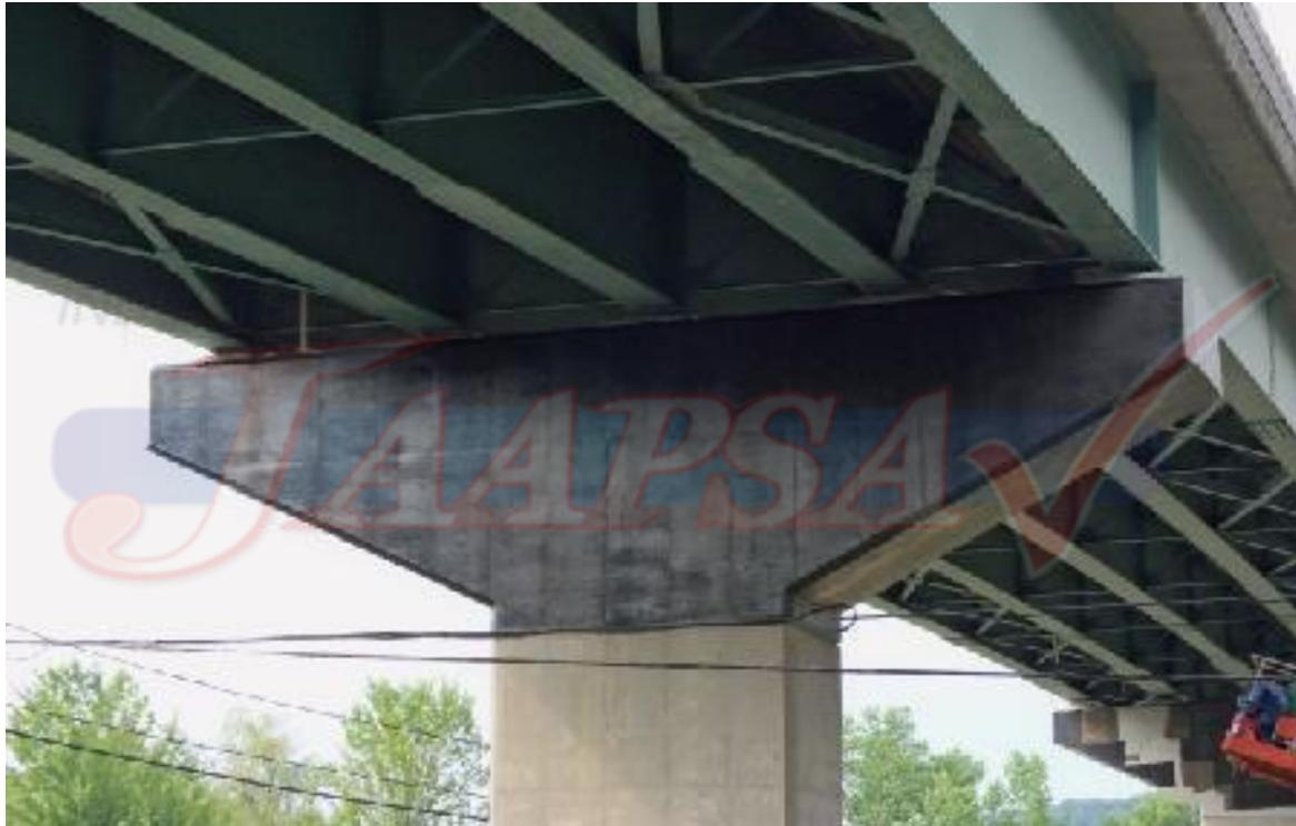
**Trabajo de refuerzo con el Sistema REFC terminado**
