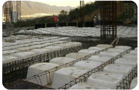
Las varillas se colocan a una distancia adecuada según las medidas del casetón
