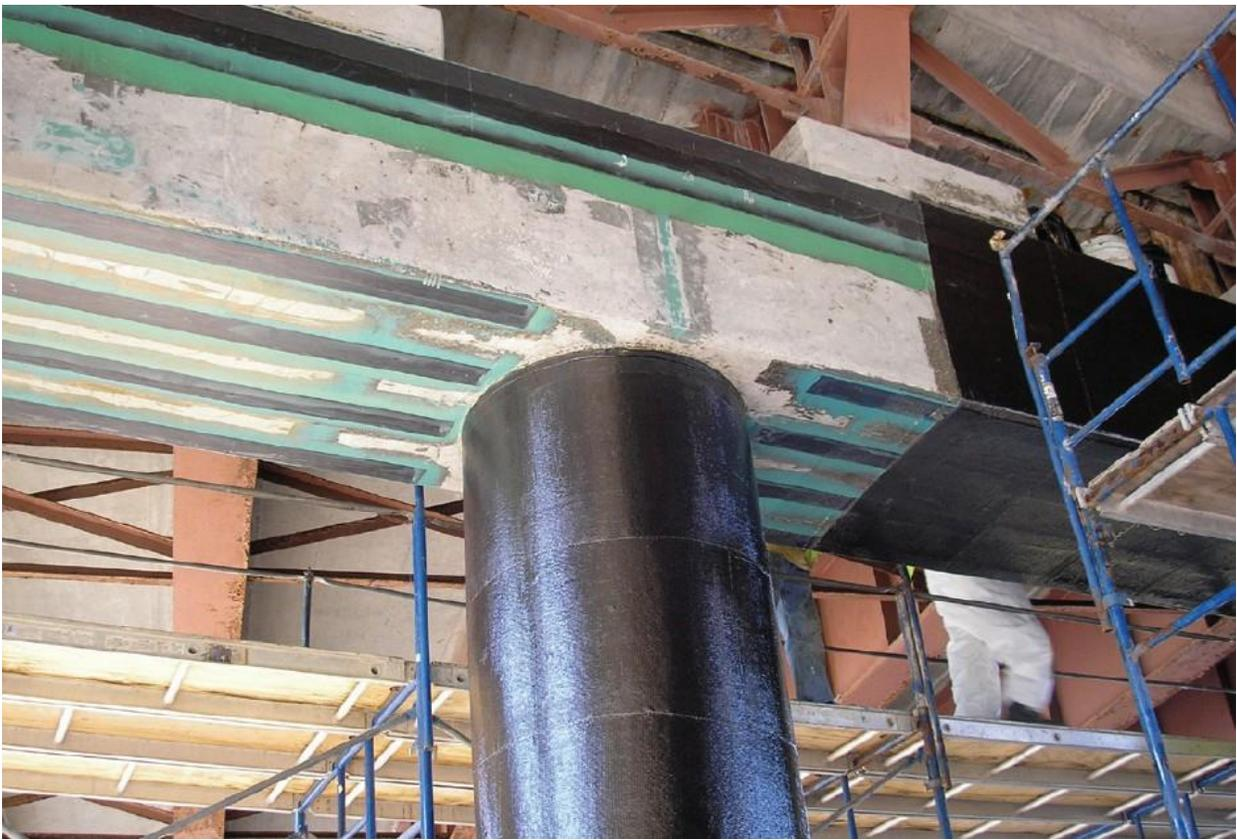
**Recubrimiento de columnas y vigas de puente con el Sistema REFC**
